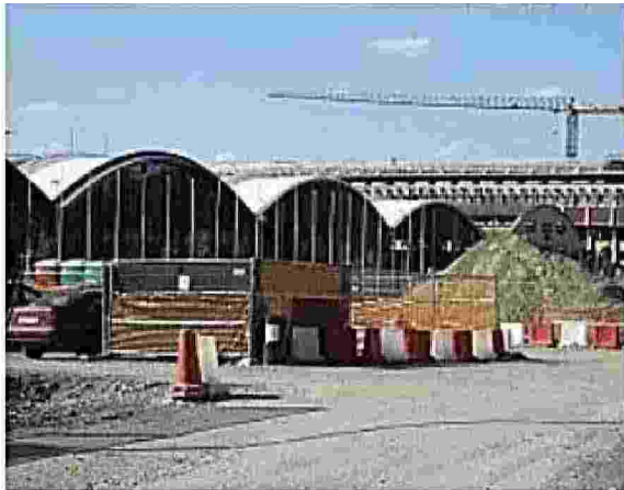
Ex Manifattura Il cantiere del Tecnopolo tra via Ferrarese e Stalingrado (LoPresse)
